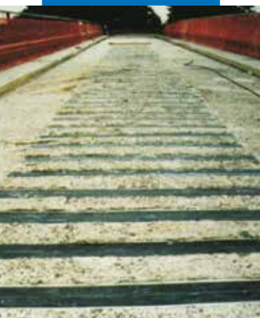
Tilto paklotas sutvirtintas Carboplate juostomis
