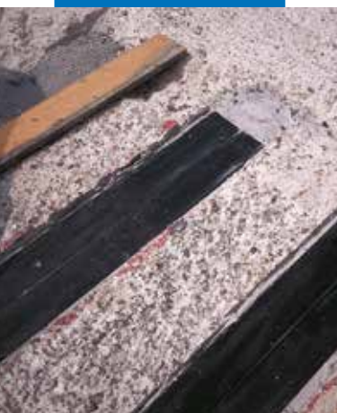
Carboplate įrengimas ant betono paviršiaus
