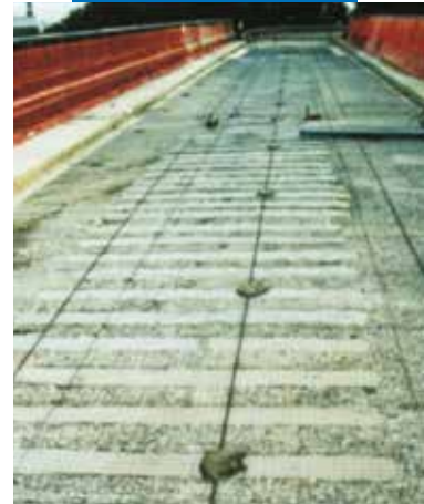
Carboplate padengtas Mapegrout BM
