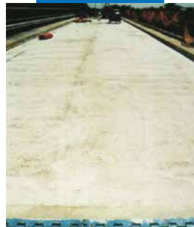
Suremontuotas tilto paklotas
