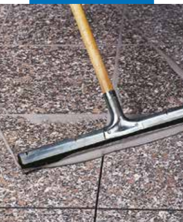
Granitinių grindų glaistymas gumine glaistykle
