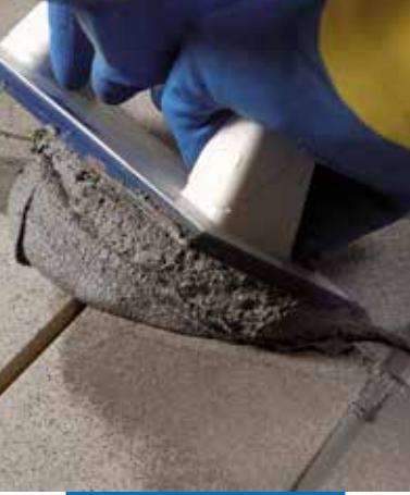
Kerapoxy CQ paskleidimas naudojant MAPEI glaistyklę
