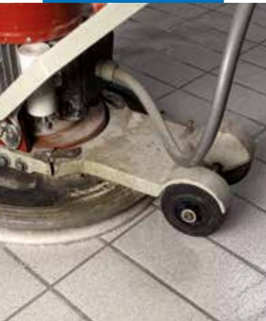
Paviršiaus valymas vandeniu ir vieno rotoriaus mašina su specialiu šlifavimo disku, pavyzdžiui, "Scotch-Brite®"
