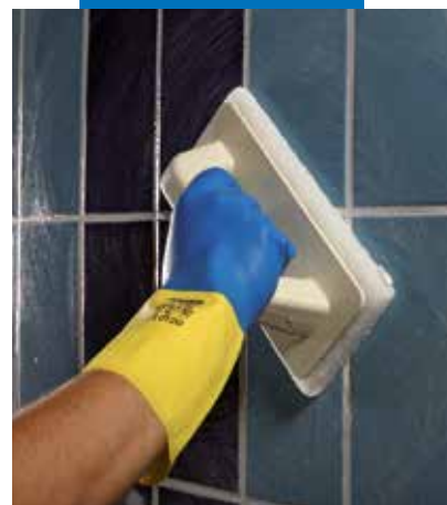
Kerapoxy CQ glaistas užtrinamas vandeniu su Scotch-Brite® kempine
