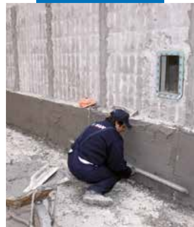
Išlyginimo išlyginimas su tiesiniu kraštu
