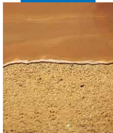
Mapecem išlyginamojo sluoksnio galutinis apdorojimas naudojant Ultraplan savaime išsilyginantį junginį
