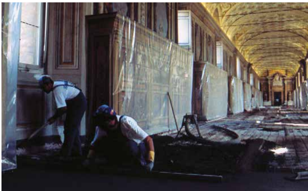
Mapecem išlyginamojo sluoksnio paskleidimas ir lyginimas – Siksto koplyčia, Vatikanas
