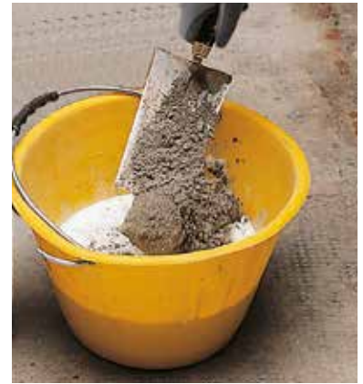
Mapecem maišymas su Planicrete. Taip gaunamas rišamasis sluoksnis
