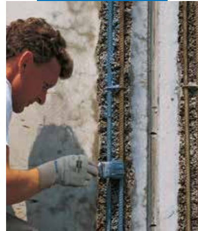
Mapefer tepimas ant armatūros
