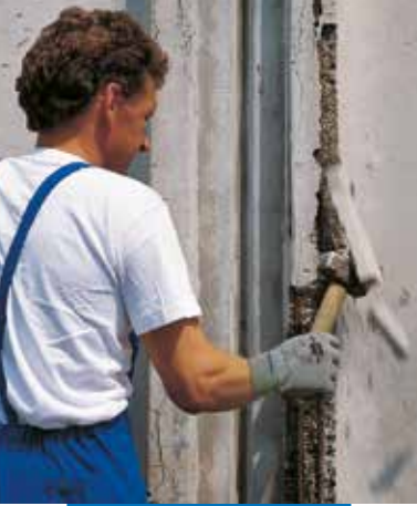
Silpno betono šalinimas
