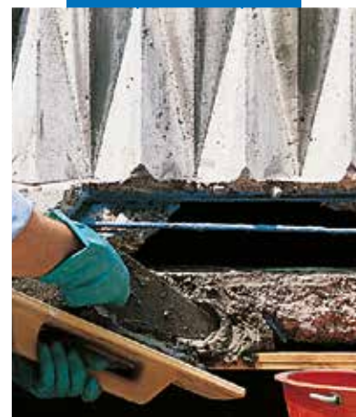
Balkono remontas naudojant Mapegrout T40
