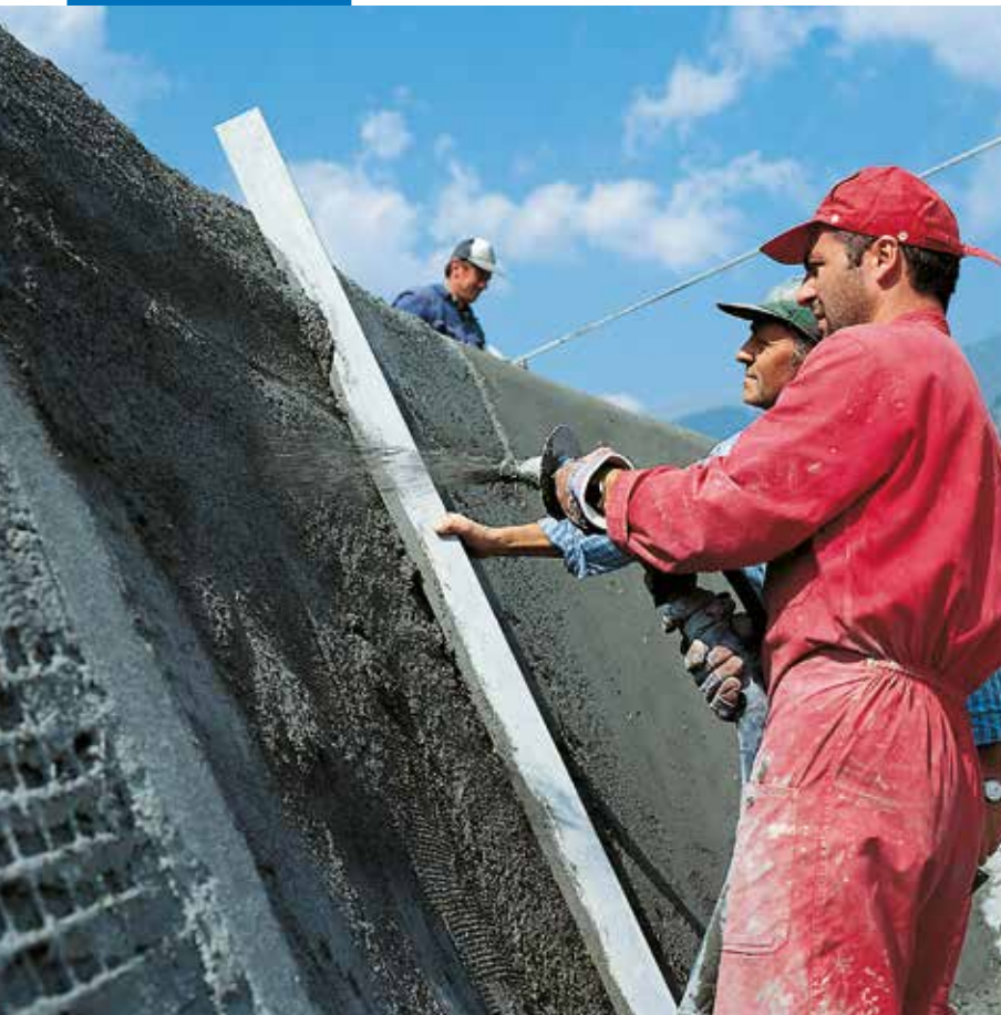
Mapegrout T40 naudojamas purškimo būdu
