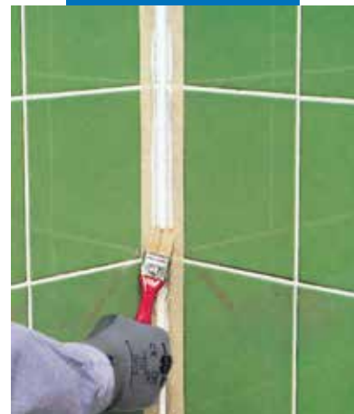
Siūlių lyginimas teptuku, sudrėkintu muiluotame vandenyje
