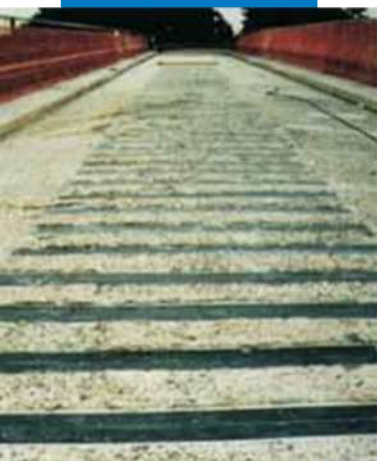
Tilto paklotas sutvirtintas Carboplate juostomis
