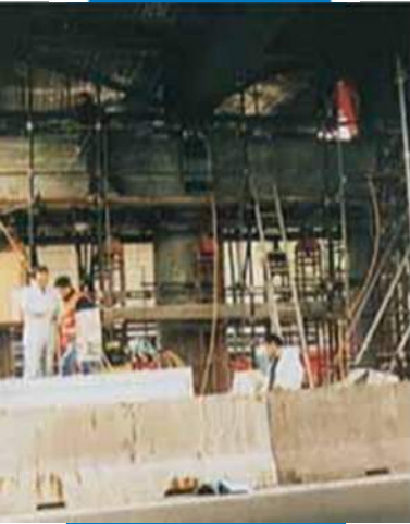
Tilto vaizdas remonto metu
