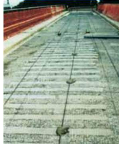
Carboplate padengtas Mapegrout BM
