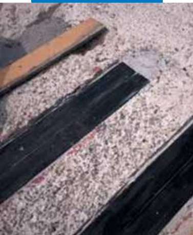
Carboplate įrengimas ant betono paviršiaus
