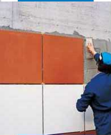
Didelių plytelių klijavimas naudojant Kerabond T + Isolastic
