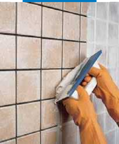
Vieno degimo sienų plytelių glaistymas glaistykle
