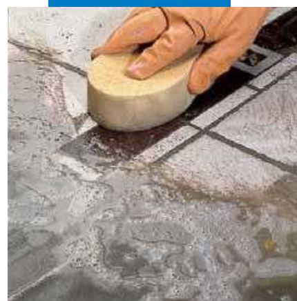
Kerminių grindų plytelių apdaila naudojantis kempine
