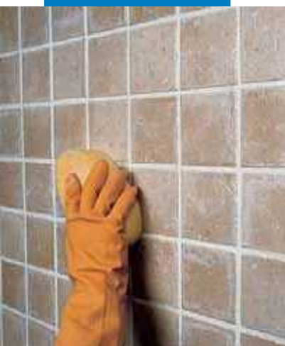
Vieno degimo sienų plytelių apdaila naudojant kempinę
