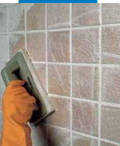
Vieno degimo sienų plytelių apdaila naudojant Scotch- Brite®
