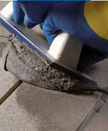
Kerapoxy CQ paskleidimas naudojant MAPEI glaistyklę
