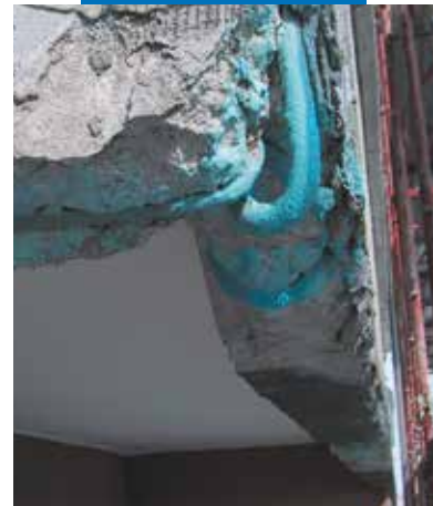
Priekinės balkono dalies armatūra apdorota Mapefer 1K
