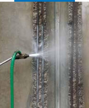
Armatūros strypų valymas
