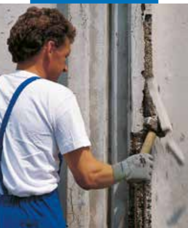
Silpno betono šalinimas
