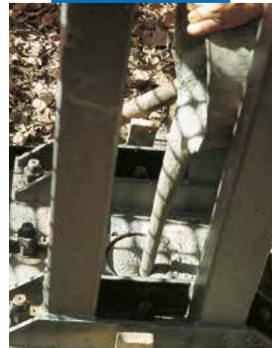
Metalinų elementų inkaravimas naudojant Mapefill
