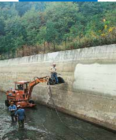
Planiseal 88 užpurškimas ant hidroelektrinės kanalo sienų
