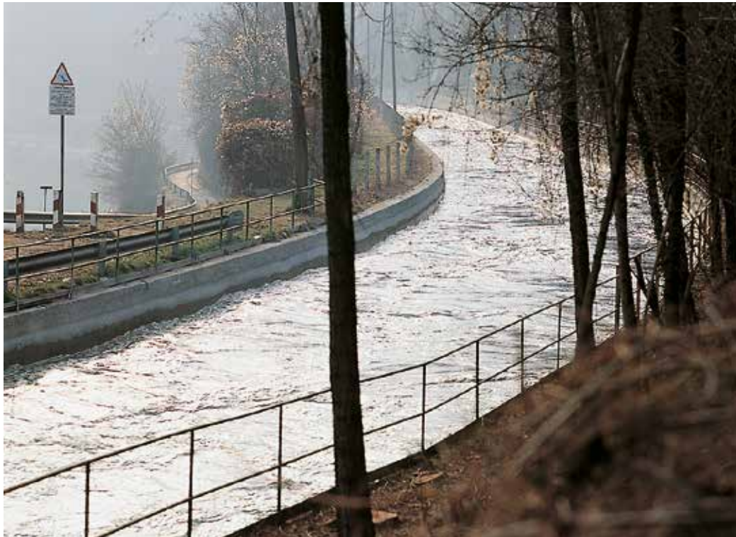
Bertini hidroelektrinės kanalas – Komo – Italija. Paviršiai apdoroti Planiseal 88
