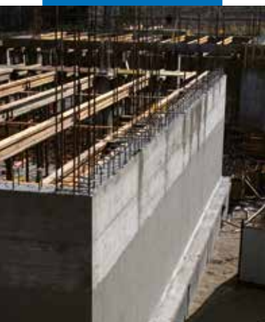
Pamatų konstrukcijų hidroizoliavimas naudojant Mapelastic Foundation
