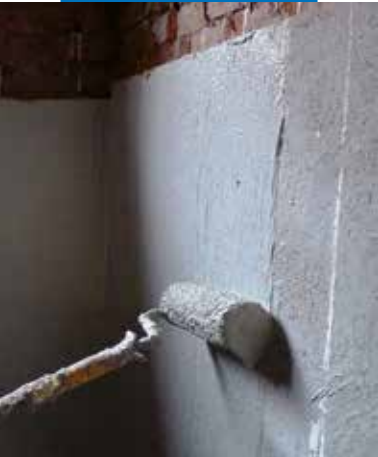
Mapelastic foundation užtepimas voleliu ant pagrindo, išlyginto naudojant Planitop HDM Maxi
