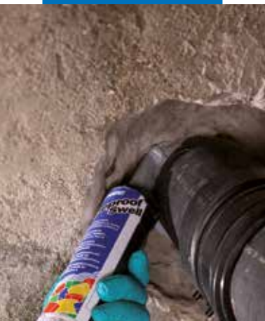
Tuštumos aplink vamzdį sandarinimas naudojant Mapeproof Swell
