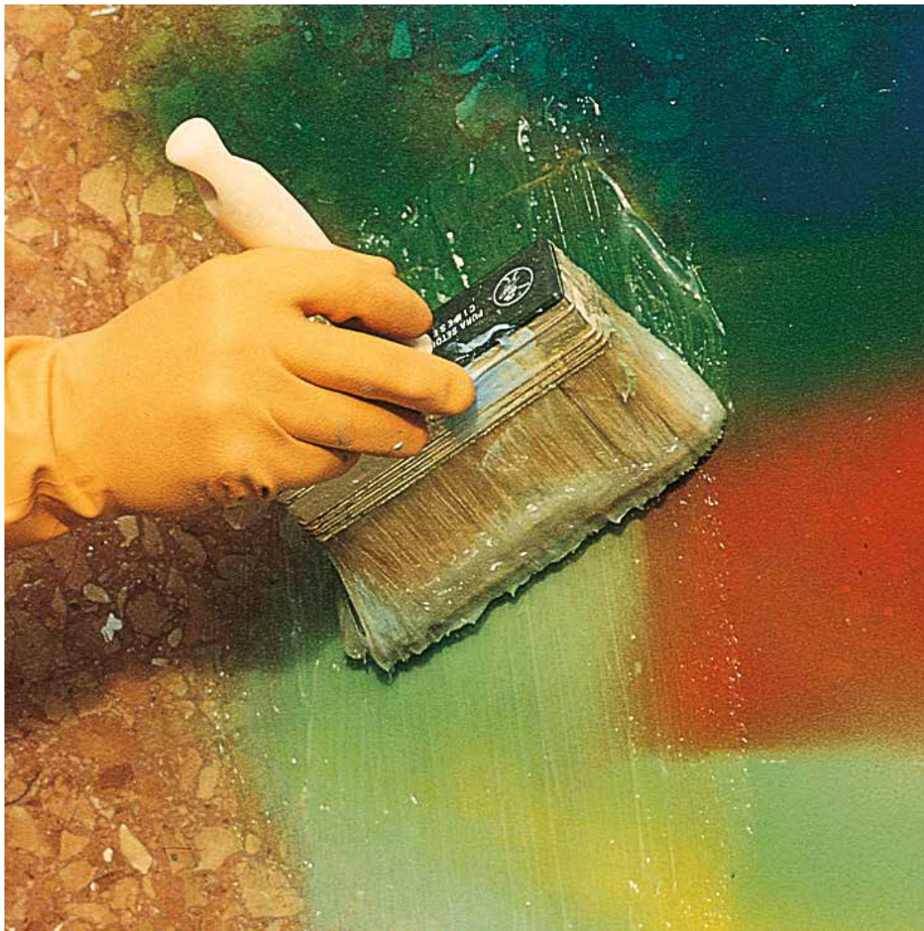
Graffiti nuplovimas nuo paviršiaus po apdorojimo produktu WallGard Graffiti Remover Gel
