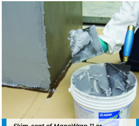
Skim-coat of MapeWrap 11 or MapeWrap 12
