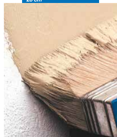
Dengiamas apdailinis /apsauginis Elastocolor Paint sluoksnis
