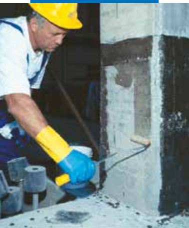
MapeWrap Primer 1 grunto tepimas
