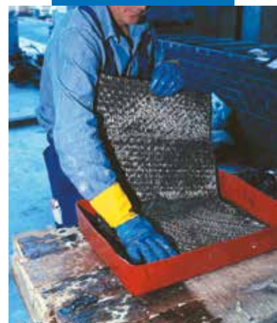
Rankinis MapeWrap C pluošto impregnavimas
