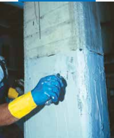
Pagrindo lyginimas naudojant MapeWrap 11 arba MapeWrap 12
