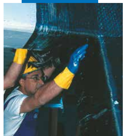
Pluošto vyniojimas ant sijų ir kolonų konstrukcijų
