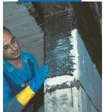
Pluošto vyniojimas ant sijų ir kolonų konstrukcijų
