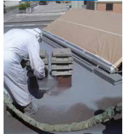
Purtop 400 M purškimas ant bituminės membranos
