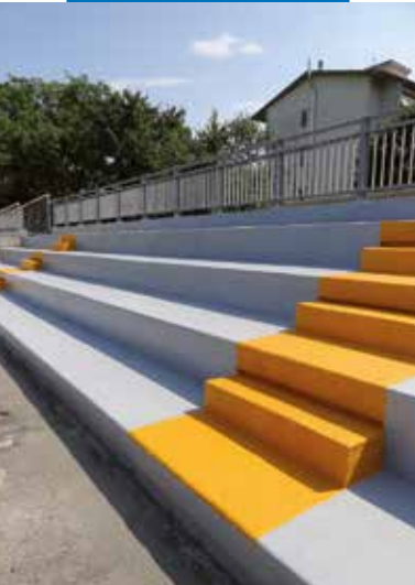
Žiūrovų tribūnų hidroizoliacija su Purtop 400 M padengtu su Mapefloor Finish 55
