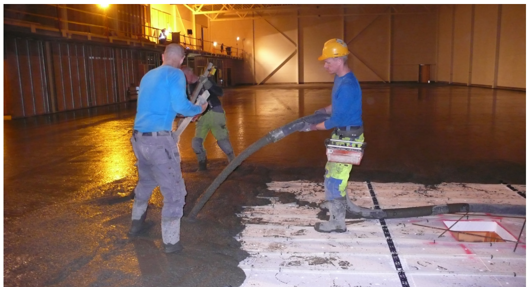
1 nuotrauka: liejamos besiūlės „Mapecrete System“ grindys, 1300 m 2 .
