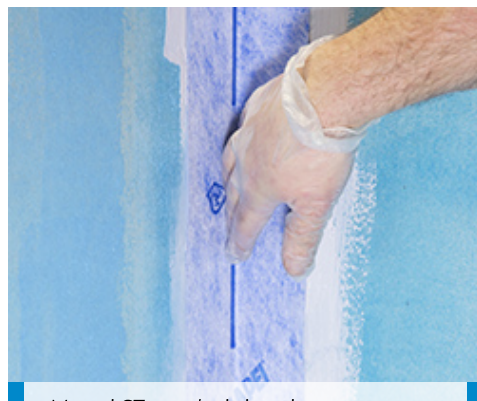
Mapei ST sandarinimo juostos įrengimas ant sienos, naudojant Mapegum WPS
