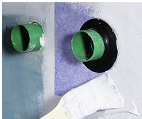
Mapei VR sandarinimo elemento įrengimas ant Mapegum WPS
