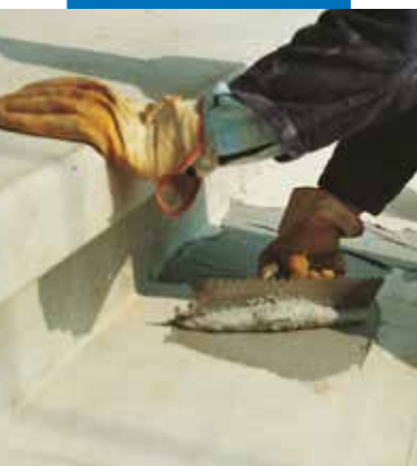
Gelžbetoninių surenkamų laiptų pakopų tvirtinimas tepant Adesilex PG1 dantytą mentele
